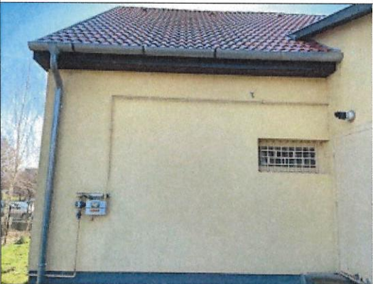
Felépítmény északkeleti oldala
