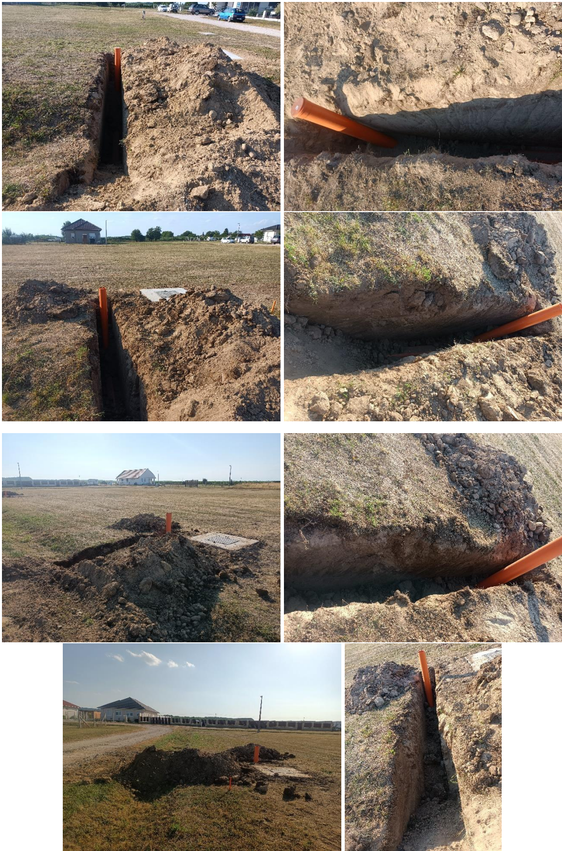
14. ábra: A Fűzfaliget téren módosítással érintett terület déli részén a négy szennyvízbekötésről készült fényképek
